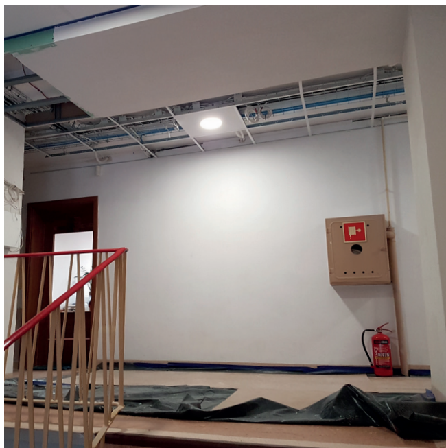
prace wewnątrz budynku Urzędu Miasta Puck
