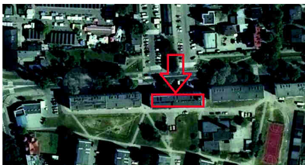
01 - Lokal użytkowy o powierzchni 151,69m 2 , położony w centrum miasta przy ul. Nowy Świat 4
