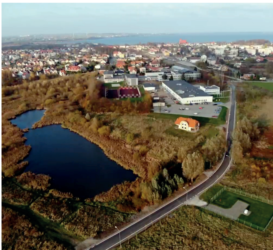
Zmodernizowana ul. Kolejowa
