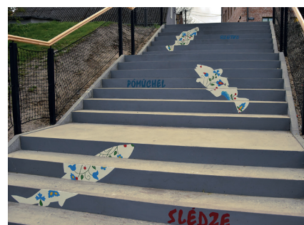
Schody po remoncie
