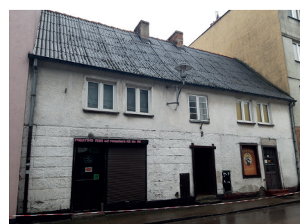
ul. Pokoju 8 przed rewitalizacją
