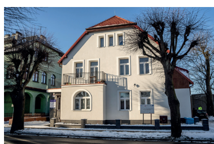
ul. Gen. J. Hallera 5 po rewitalizacji
